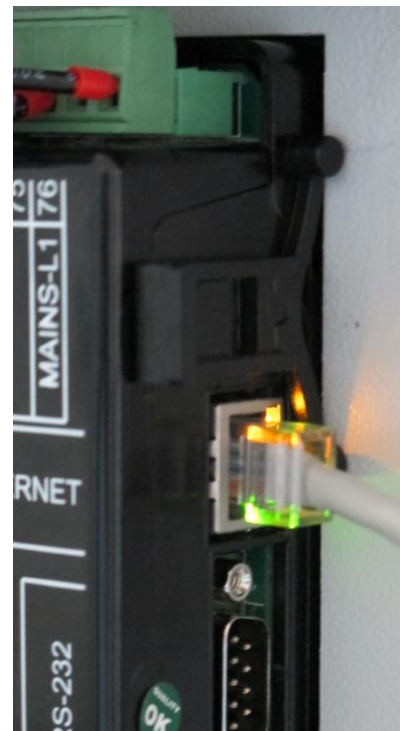
Instalação do suporte do tipo autorretenção
