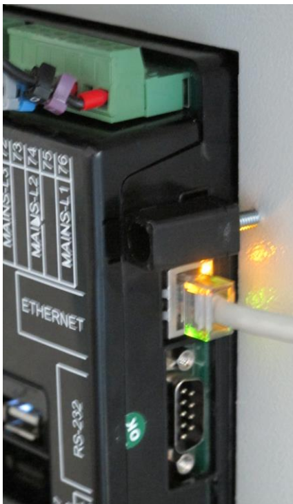
Instalação do suporte do tipo parafuso
