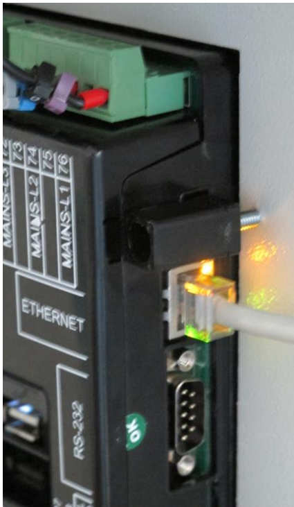
Instalación de la traba tipo tornillo
